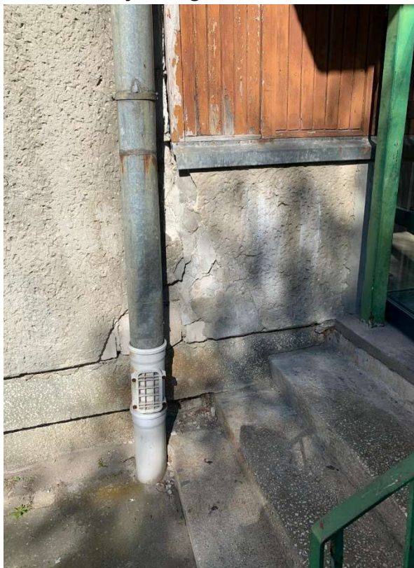
Fot. 1. (Zarysowania powierzchniowe i ubytki związane z niepoprawną obróbką blacharską)
