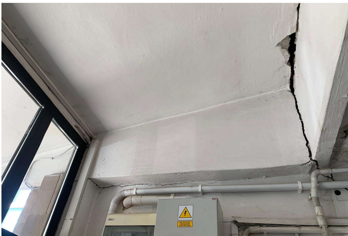
Fot. 15. (Zarysowanie poziome żebra bocznego usztywniającego zadaszenie)
