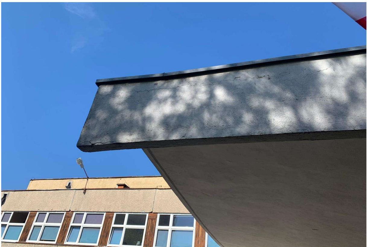
Fot. 17. (Zarysowanie poziome powierzchni na żębrze usztywniającym zadaszenie)
