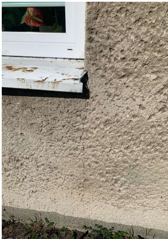
Fot. 1. (Zarysowania powierzchniowe i ubytki związane z niepoprawną obróbką blacharską)
