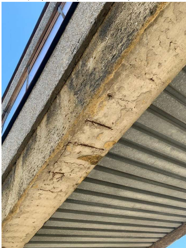
Fot. 7. (Odślonięte pręty zbrojeniowe na spodzie łącznika)
