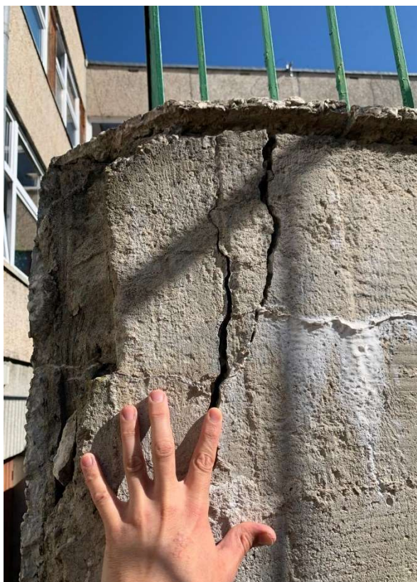
Fot. 10. (Zarysowania murków betonowych zewnętrznych)
