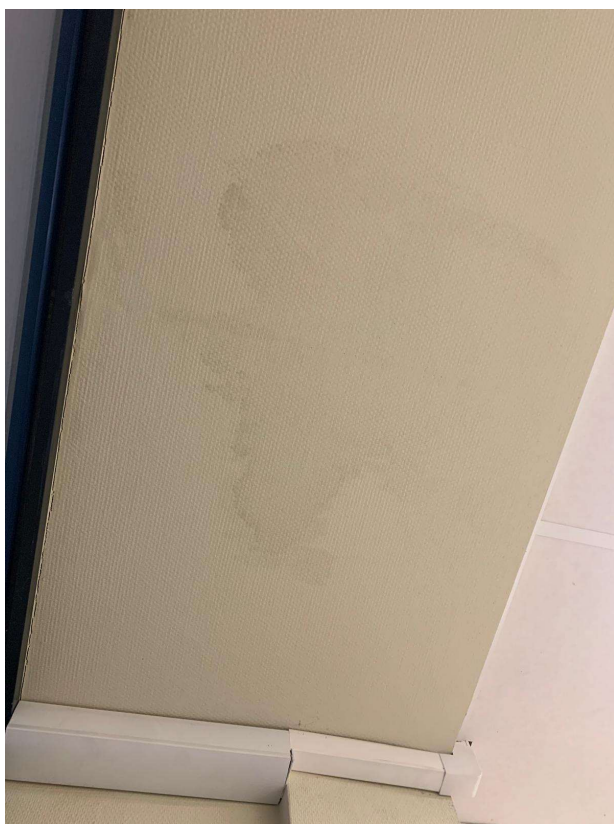
Fot. 9. (Wilgoć na skutek nieszczelności styku)
