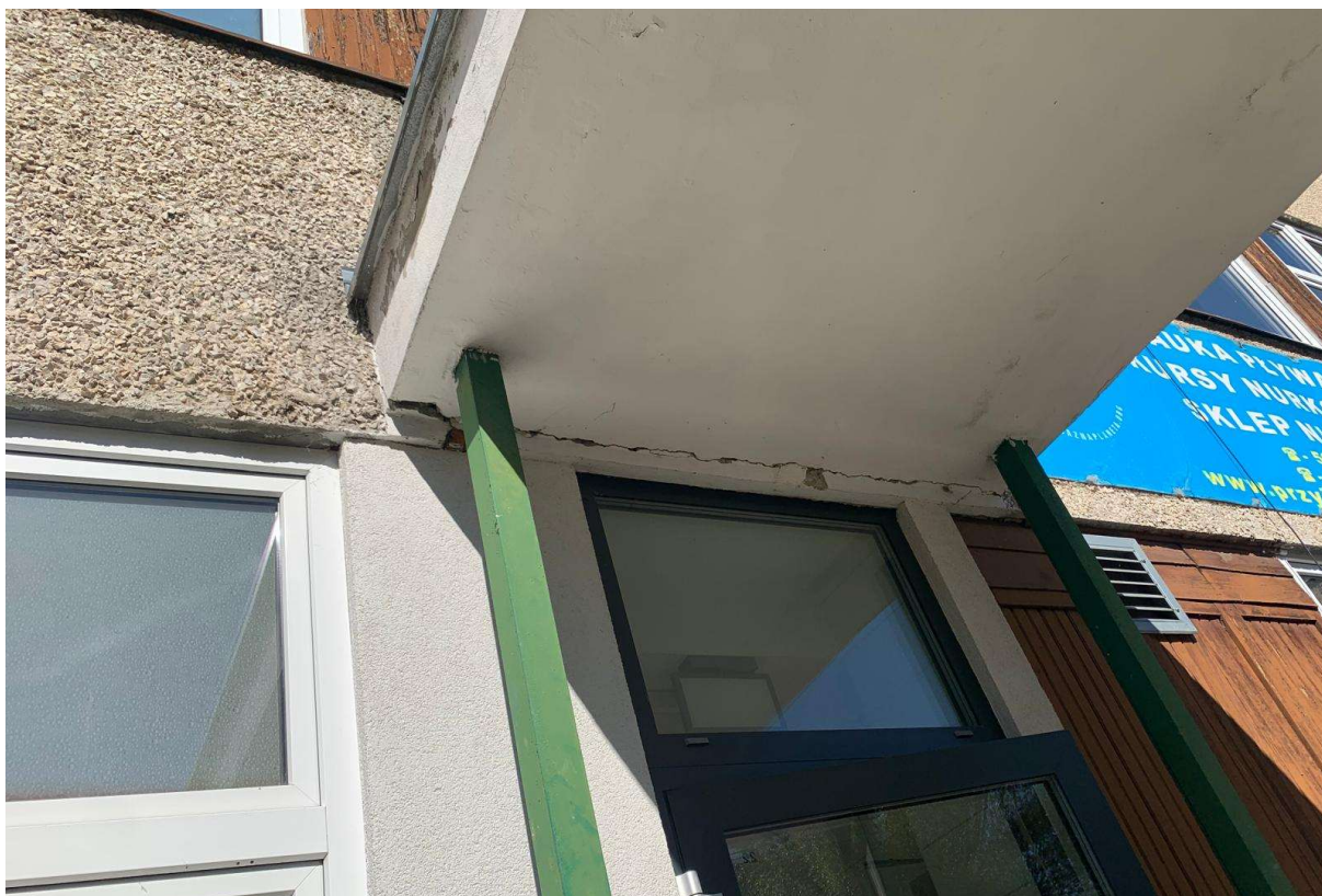
Fot. 6. (Zarysowanie poziome na styku zadaszania z elewacją)
