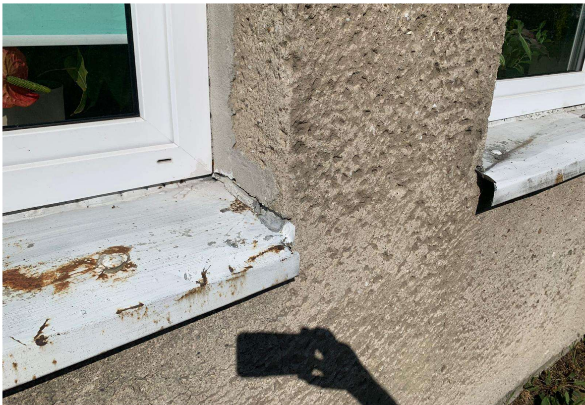
Fot. 2. (Niepoprawnie wykonana obróbka blacharska parapetów zewnętrznych oraz widoczna korozja parapetów)
