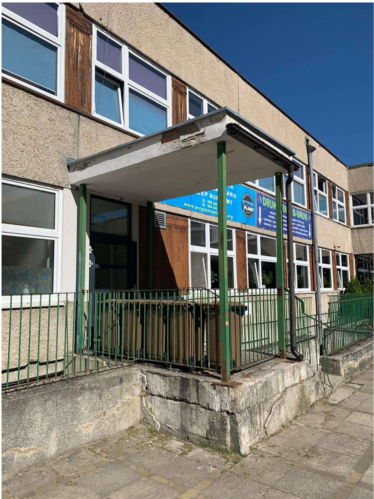
Fot. 5. (Odspojenia tynku zadaszona, korozja słupków stalowych)
