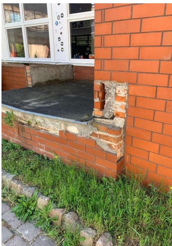
Fot. 11. (Zniszczenia na murkach ceglanych)
