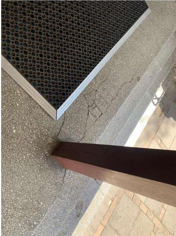
Fot. 16. (Zarysowanie w obrębie słupa stalowego podpierającego zadaszenie )
