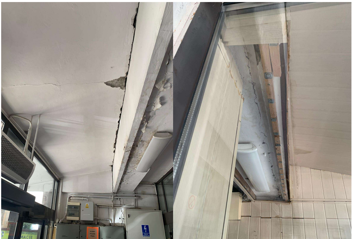
Fot. 13. (Kontynuacja rysy na suficie w pobliżu podciągu)
