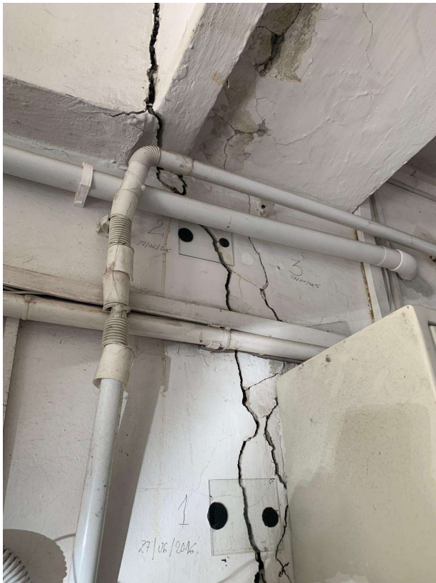
Fot. 12. (Zarysowania na ścianie zewnętrznej na styku konstrukcji wejścia i budynku. Plomby szklane.)
