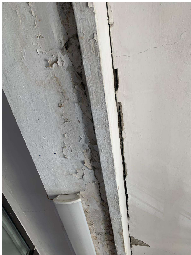
Fot. 18. (Odsparowanie tynku na podciągu przy styku z zadaszeniem)
