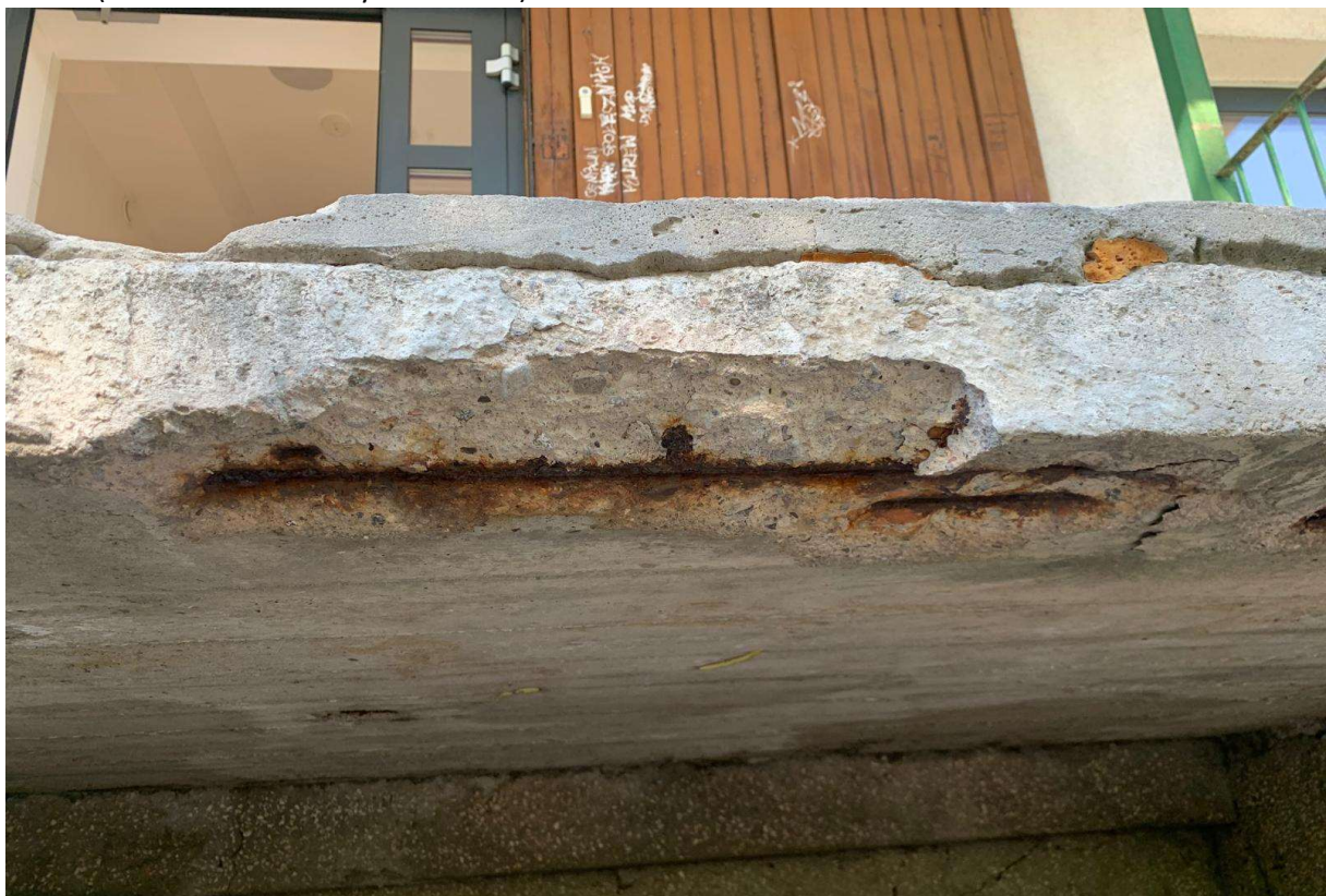
Fot. 4. (Odspojona otulina podestu, korozja pręta zbrojeniowego)
